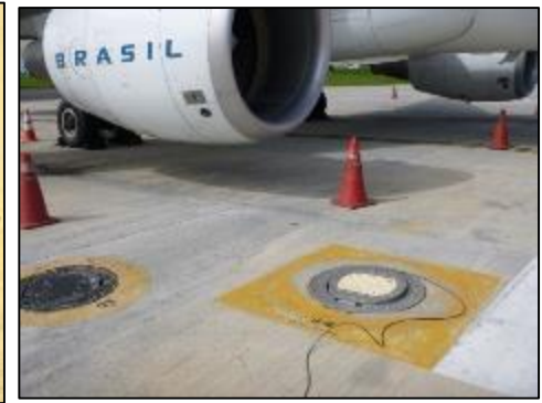
Tubulações de combustível
